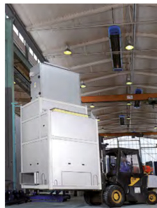
Einfacher Transport durch integrierte Gabelstaplerkufen und Kranösen
